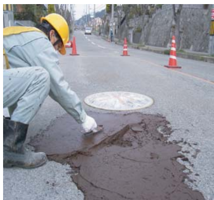
Uコートタフによる段差補修
