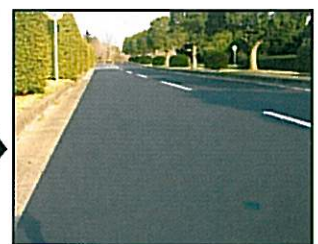
Uコート仕上がり (養生中)
