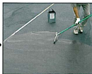
Uコート塗布 (レール等で簡単に塗布可能)
