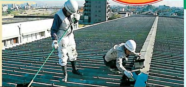
鉄板屋根のFLコート
