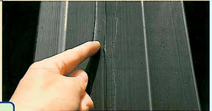
鉄板屋根にコーティングされたFLコート
